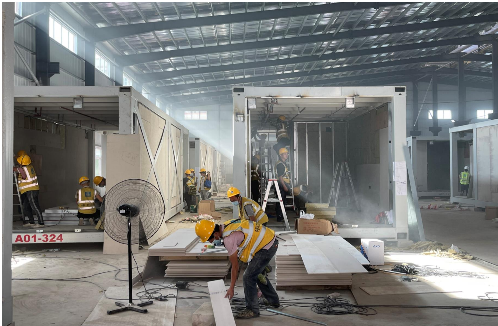
工廠加工照片（結構）
