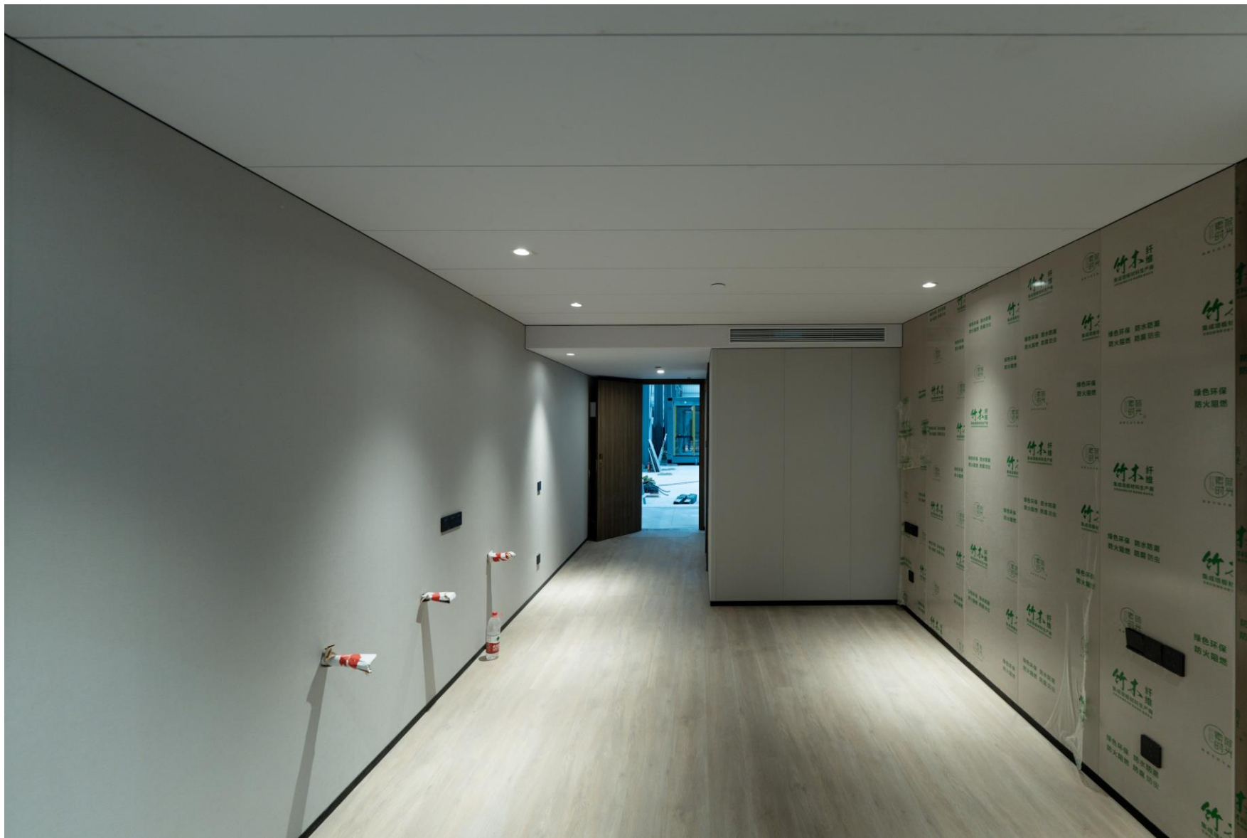
工廠加工照片（裝修、機電）
